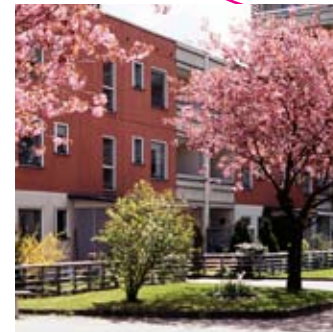
哥德堡(Gothenburg)这个从70年代起拥有255座公寓的郊区居民区, 正在进行重新整修, 结果可以将其能源消耗降低40%。
